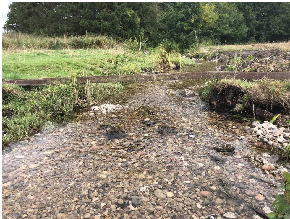
Figur 33: Eksempel på vandløbsstrækning, hvor der blevet udlagt grus og afsluttende skjulsten (foto fra vandløbsprojekt i Tokkerup Å).
