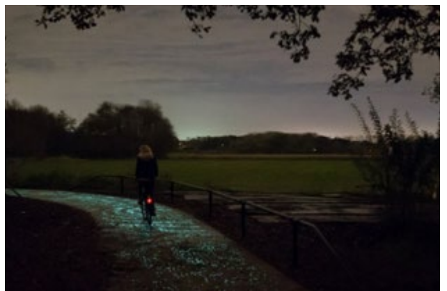
Eksempel på sti udført med selvlysende belægning
