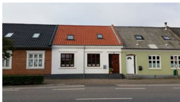
Eksempel på facaderenoveringer i bygader
