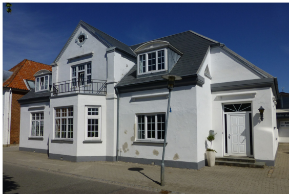
Eksisterende, og påkørt, parklampe i Vestergade foran en flot renoveret ejendom
