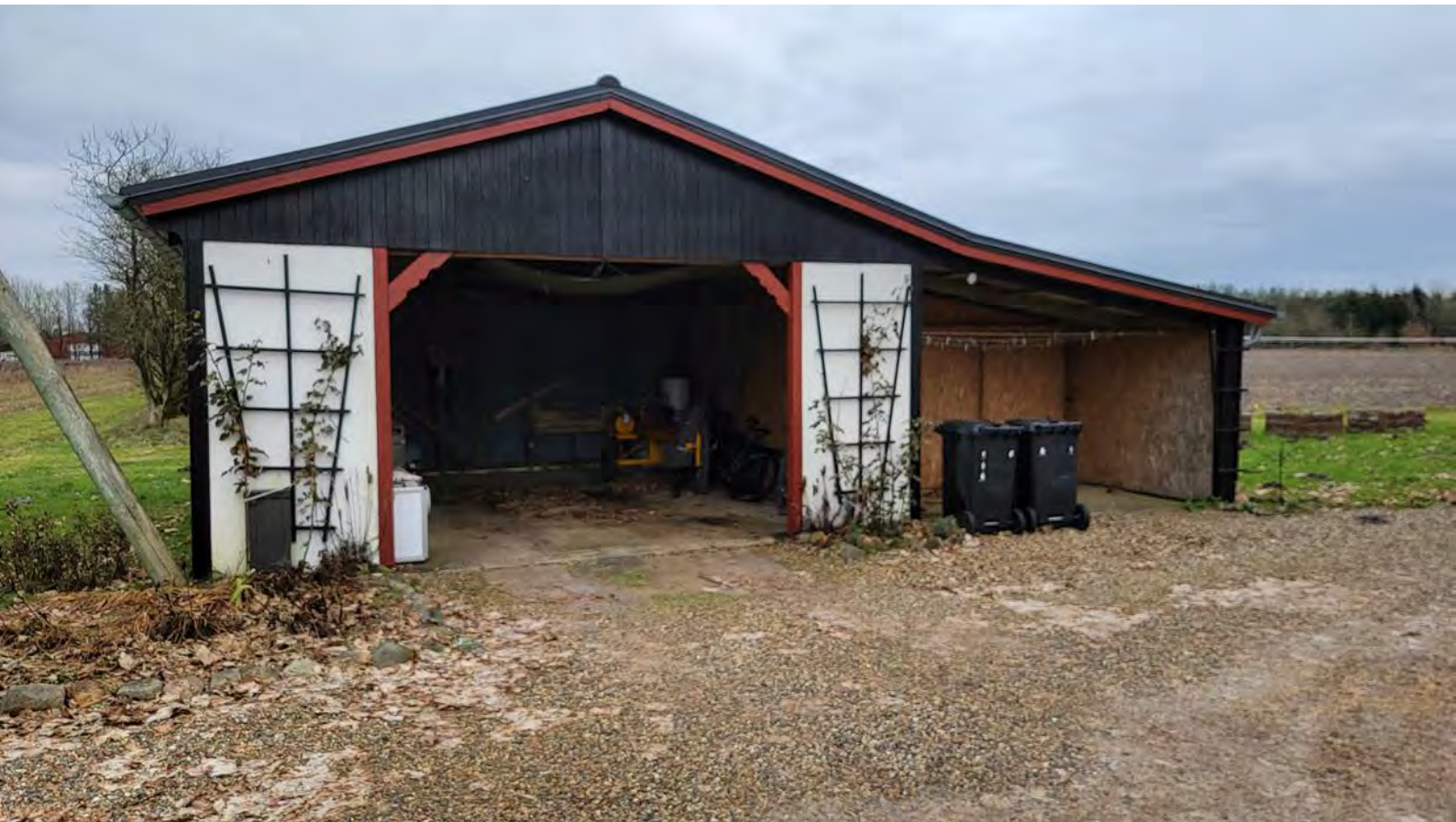
Figur 4. Tilhørende carport og skur på Stadionvej 65.
