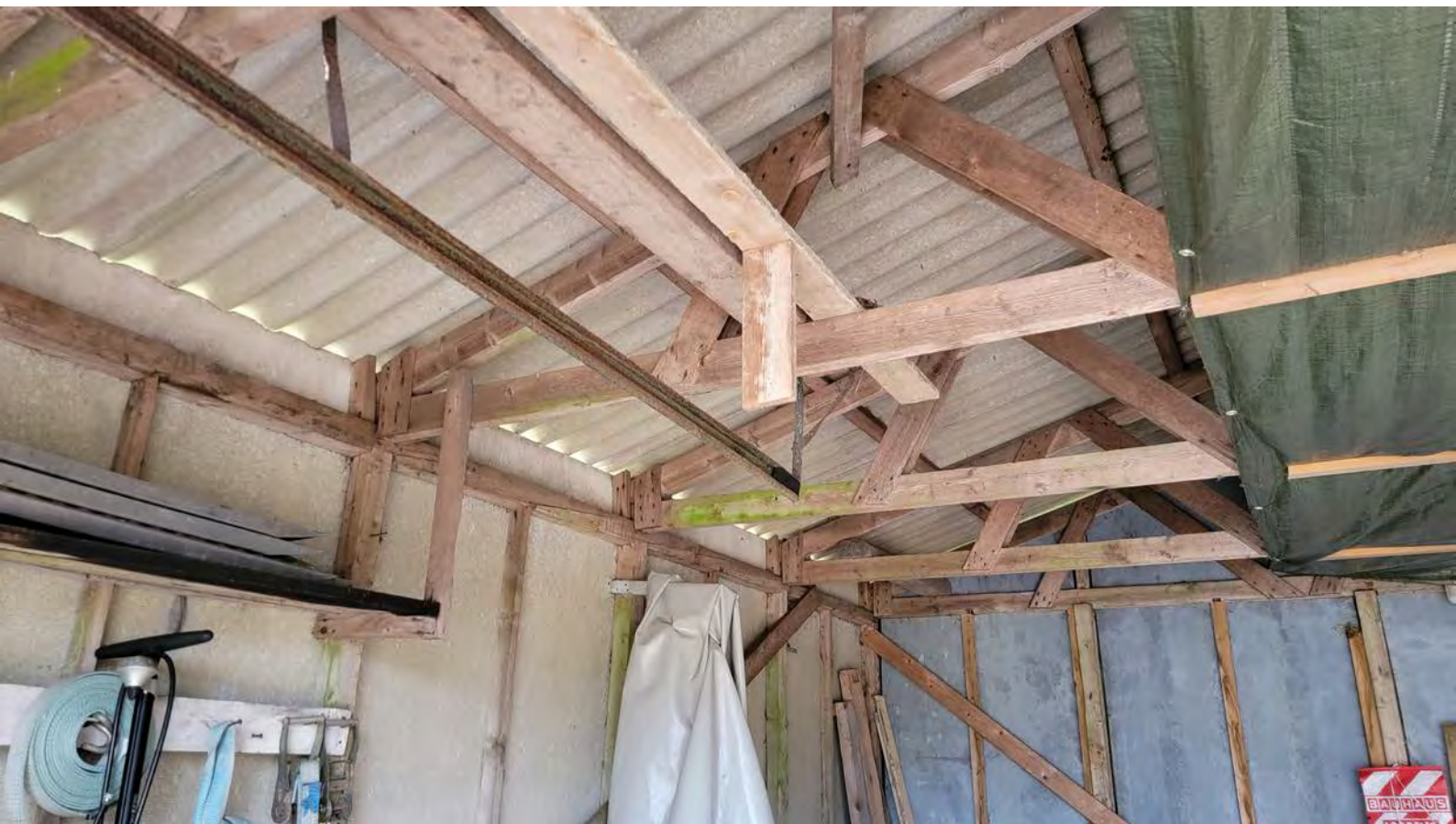
Figur 5. Tagkonstruktionen af carporten og skuret på Stadionvej 65.
