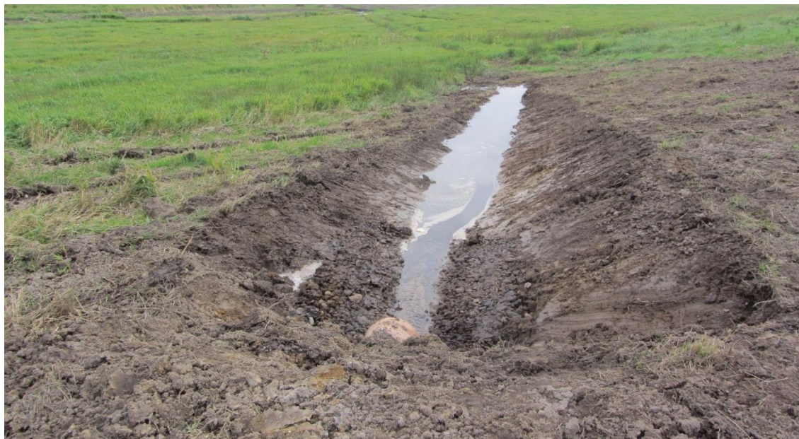
Figur 26 Nyetableret drænudløb i projektgrænsen til ny terrænnær grøft og videre udløb over terrænen ved Birkemosen, Kolding.
