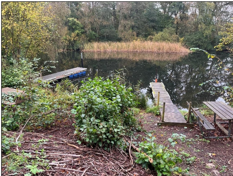
Foto af de to eksisterende broer. Broerne fjernes og der opføres en nyt broanlæg bestående af to broer som vist på nedenstående eksempelfoto.
