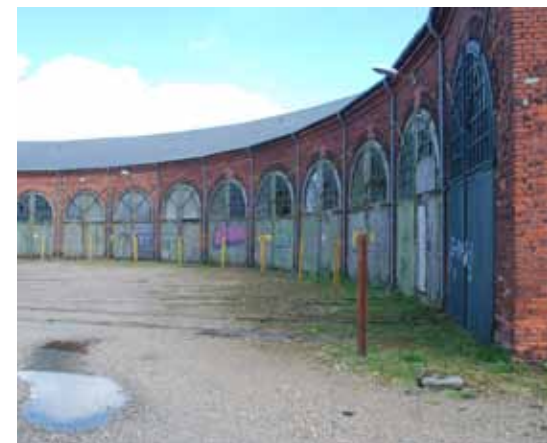
foto: den fredede remise
