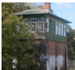
Kommandoposten før renovering
