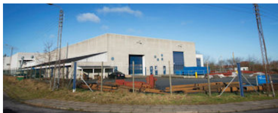
Vestasbygningen som omdannes til GAME Streetmekka
