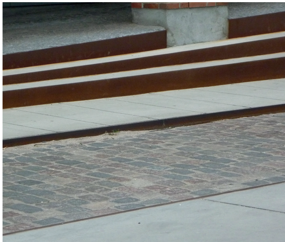
EKSEMPEL PÅ MATERIALESAMMENSÆTNING - Odense Havn - Institutøbt beton, cortenstål og mindre sten i varierende nuancer.
