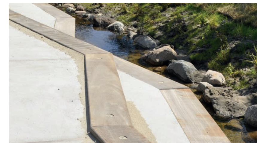
EKSEMPEL TIL INSPIRATION - Blokhus Bæk - Træhammer benyttes som afslutning på kanter på Banebypladsen
