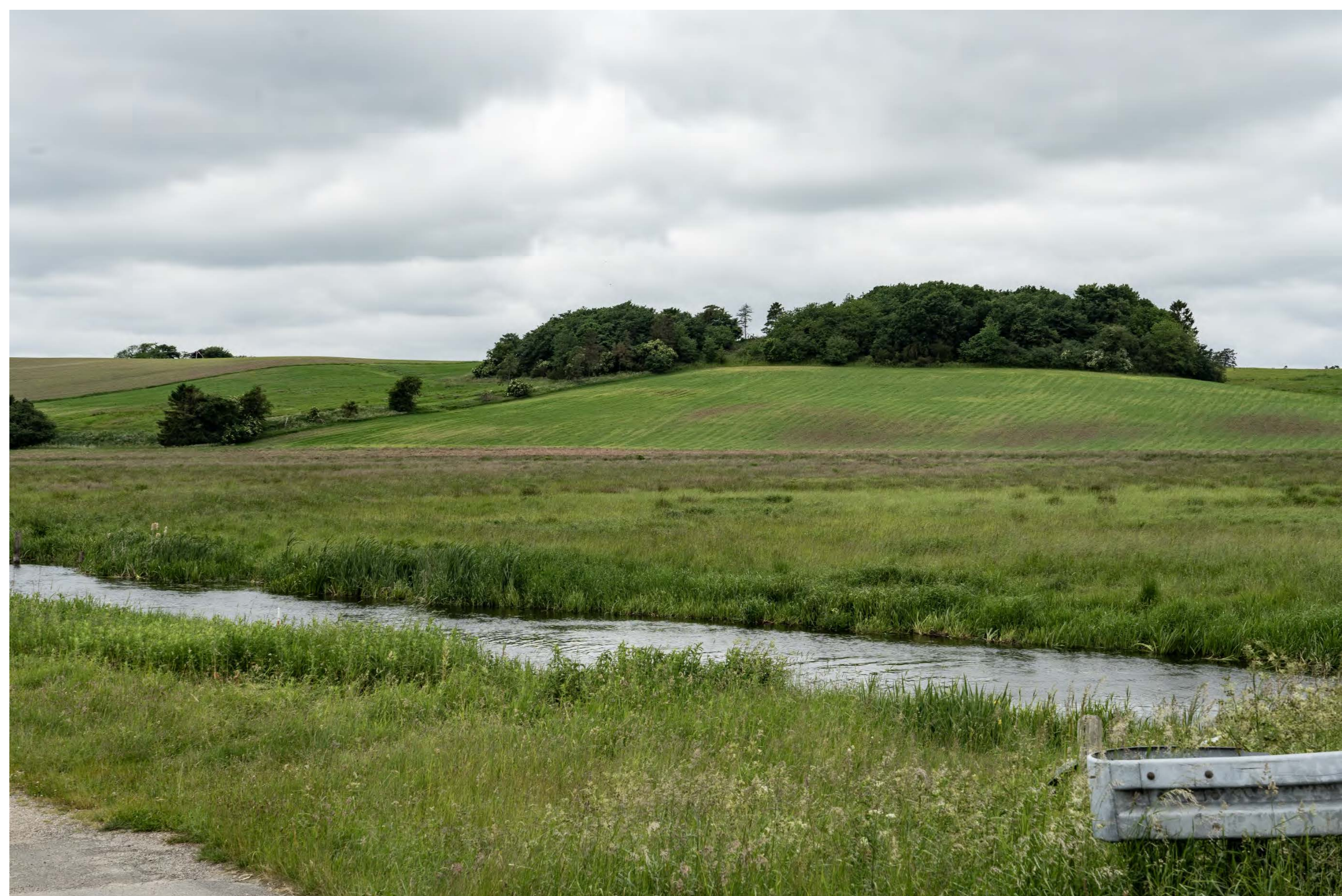
17: Løgstrøvej, Skals Å Eksisterende forhold
