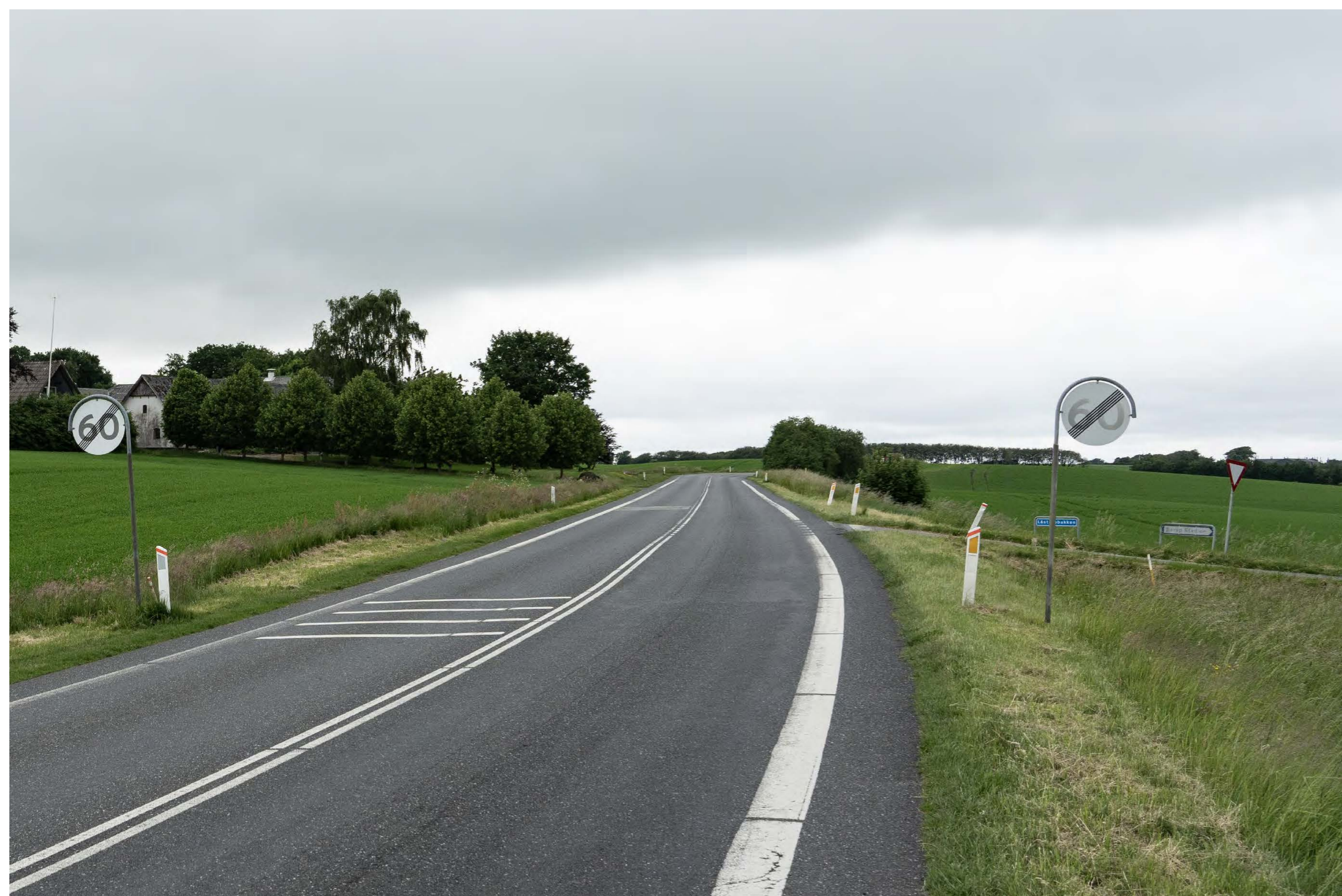
12: Løgstrøvej, nær Låstrup Eksisterende forhold
